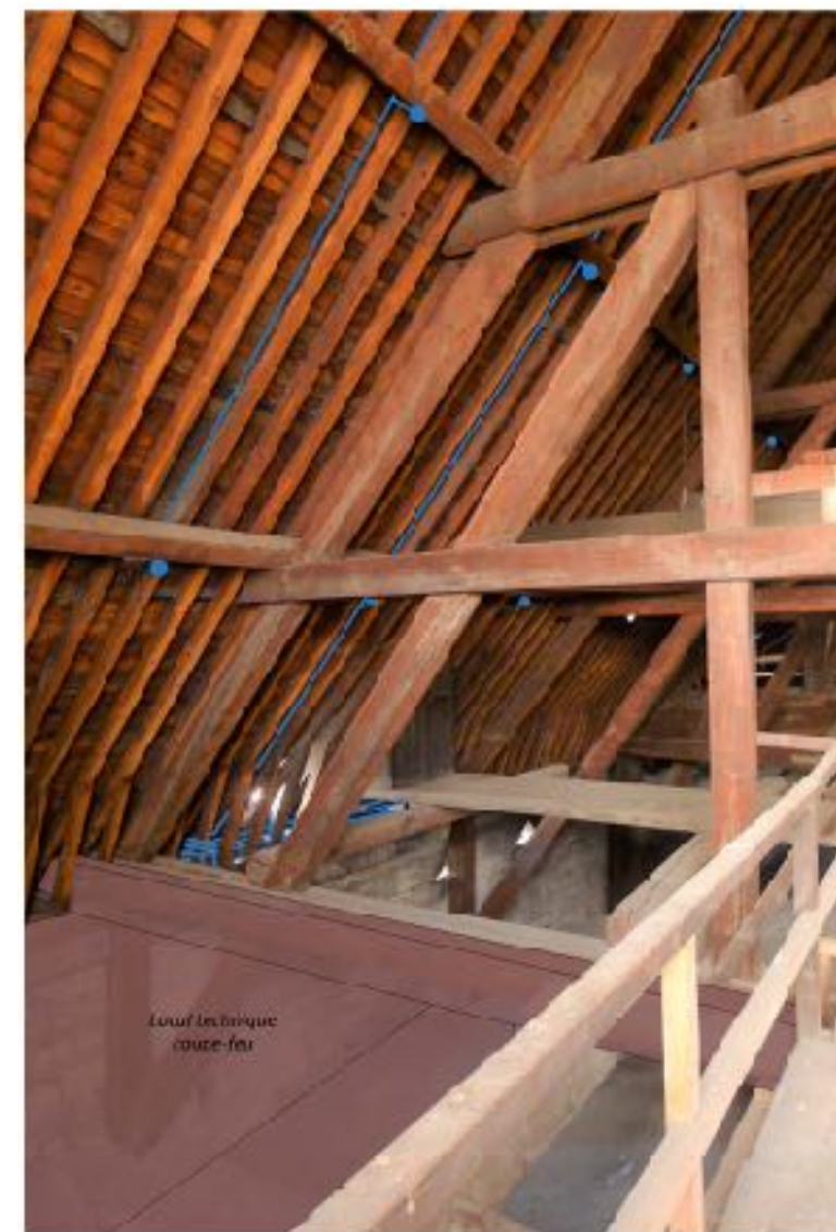
Photographie 1 - Vue avant incendie du bras de transept sud
