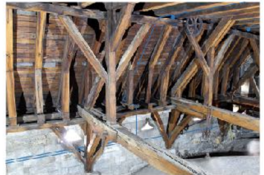
Photographie 3 - Vue avant incendie de la nef
