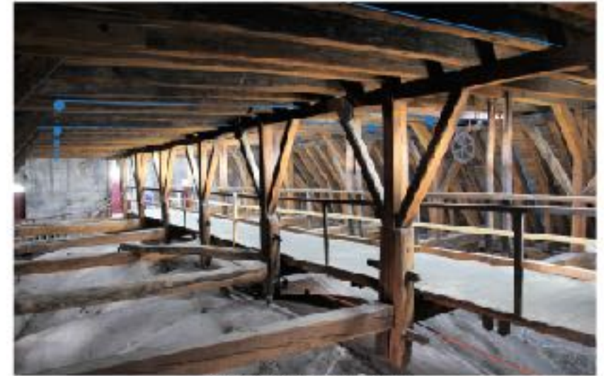
Photographie 2 - Vue avant incendie de la nef
