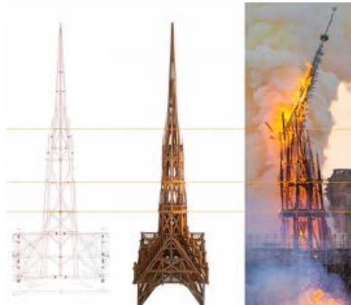
Identification des zones potentiellement affaiblies par un incendie dans la flèche
