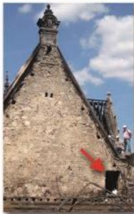
Propagation du feu au comble principal par passage dans le mur pignon de pierre
